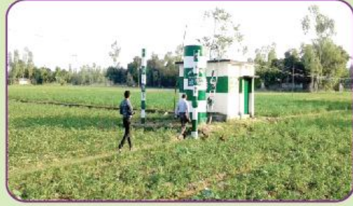
রংপুর জেলার কাউনিয়া উপজেলায় প্রকল্পের মাধ্যমে ১ কিউসেক সাকশন মোড নলকূপ স্থাপন ও ভূগর্ভস্থ সেচ নালা নির্মাণ
